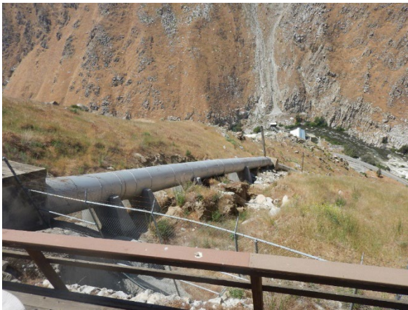
Forebay Spillway Pipe
